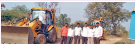
ఫార్వేషన్ రోడ్డు నిర్మాణాన్ని పరిశీలిస్తున్న మున్సిపల్ కమిషనర్ జగ్జీవన్
