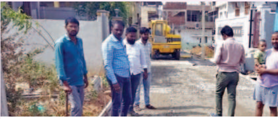
రోడ్డు నిర్మాణ పనులను పరిశీలిస్తున్న మున్సిపల్ వైస్ చైర్మన్ దారం శంకర్
